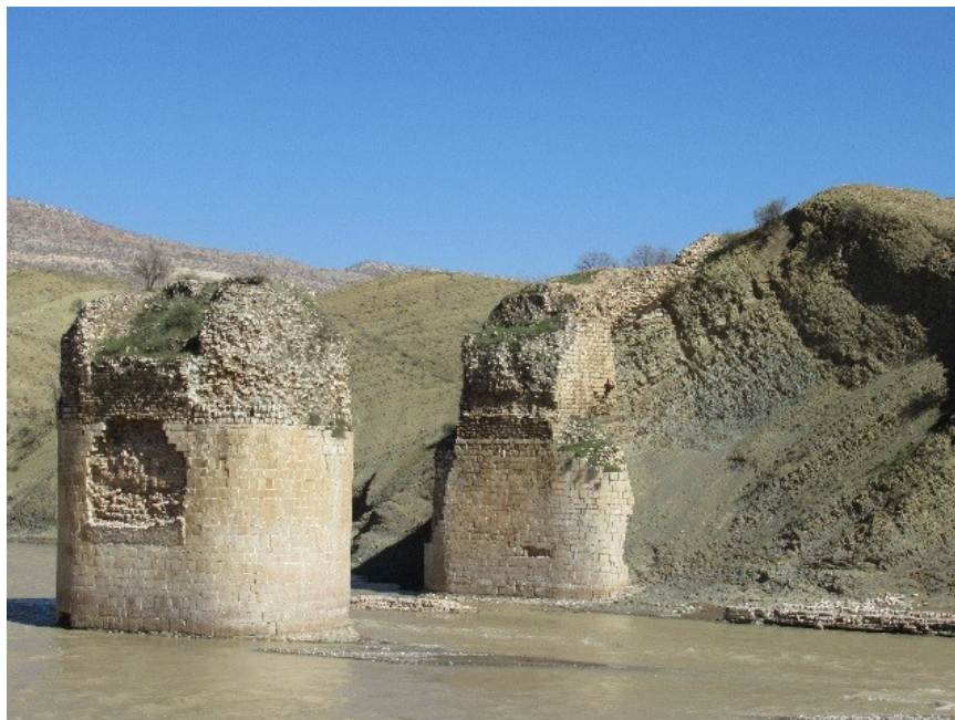
عکس ۷- تصویر صخره طبیعی به عنوان فونداسیون، پایه در بستر خیس؛ پل کشکان (عکاس: مهدی پیرحیاتی، محوطه تاریخی پل کشکان، ۱۳۹۸/۰۹/۱۴)
