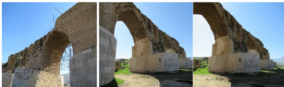
عکس ۳- تصاویری از جبهه شمالی پل کشکان (عکاس: مهدی پیرحیاتی، محوطه تاریخی پل کشکان، ۱۳۹۸/۰۹/۱۴)
