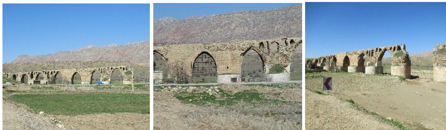
عکس ۲- تصاویری از جبهه جنوبی پل کشکان (عکاس: مهدی پیرحیاتی، محوطه تاریخی پل کشکان، ۱۳۹۸/۰۹/۱۴)
