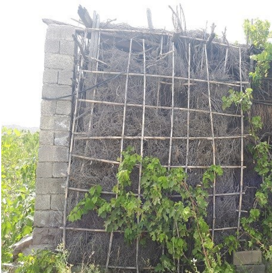
تصویر ۷- آدوربند با دیوار بتنی (بلوک)، تلفیق مصالح سنتی و جدید در منطقه کوهستانی در دسک، جبالبارز جیرفت، (صحت منش ۹۷/۰۴/۲۸)
