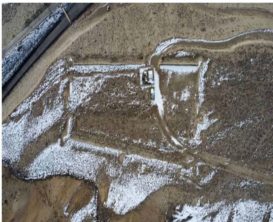
عکس ۶- تصویر هوایی قلعه طزره از جبهه شمالی: مبین مقاوم‌سازی و مکانیت (مأخذ: نگارندگان)
