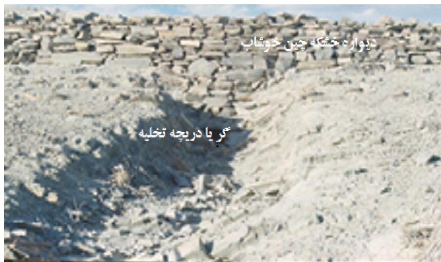
عکس ۴- دریچه تخلیه (نام محلی گر: Gar) در خوشاب
