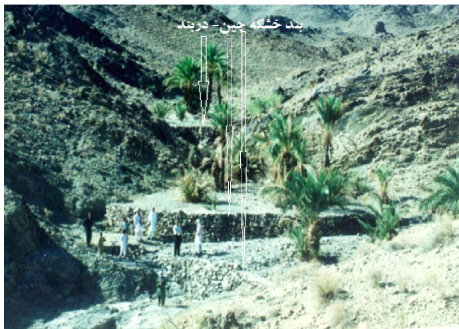
عکس ۷- نمونه‌ای از سامانه دربنده مرکب در منطقه نیکشهر بلوچستان
