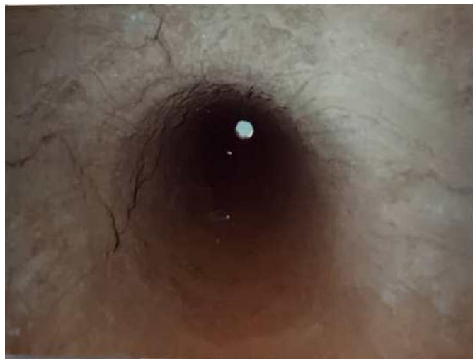
عکس ۱۲- سقف بخش اصلی آسیاب و روشنی گاه در ارتفاع ۴۰ متری پیداست. ۱۳۷۸
