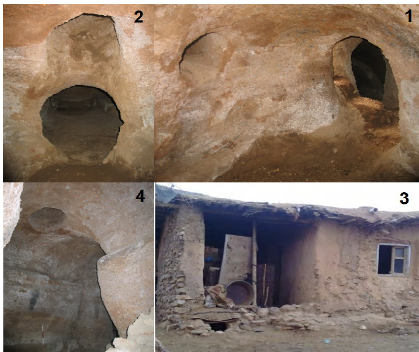
عکس ۱۲- موقعیت هواکش‌ها- در عکس های ۱ و ۲ در دیوار و بالای چپک به صورت اریب کننده شده‌اند و در عکس ۳ هواکش به حیاط راه دارد (عکس ۳ مهدی فتاحی دارنی - عکس های ۱، ۲ و ۴ نگارندگان، ۱۳۸۵)
