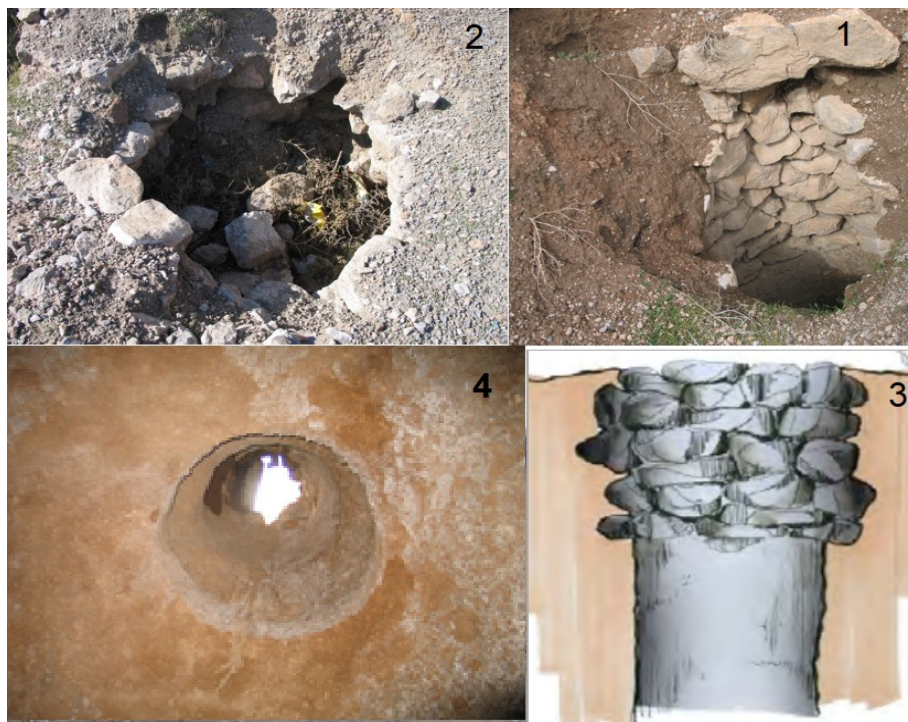
عکس ۱۳- فرم هواکش و نحوه سنگچین بخش فوقانی آن (عکس ۳ از مرکز اسناد پایگاه
