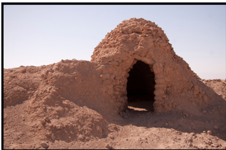
عکس ۱۳- نمونه‌ای از کلاه‌فرنگی ساخته‌شده قنات صدرآباد اردکان واقع در شمال شهر بفروثیه (۱۰ اسفند ۱۳۹۲، نادر پیری اردکانی)
